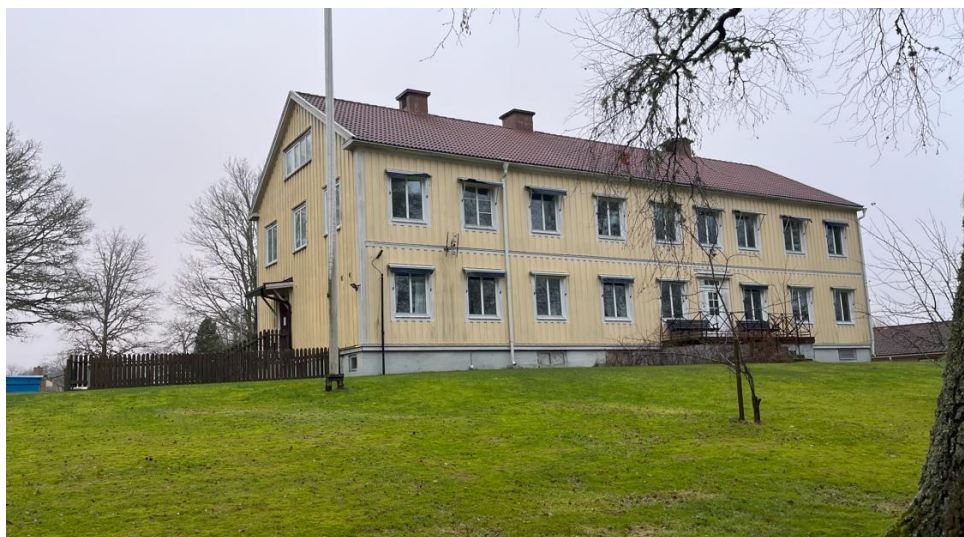
Byggnaden från nordväst. Bildkälla: Norconsult
