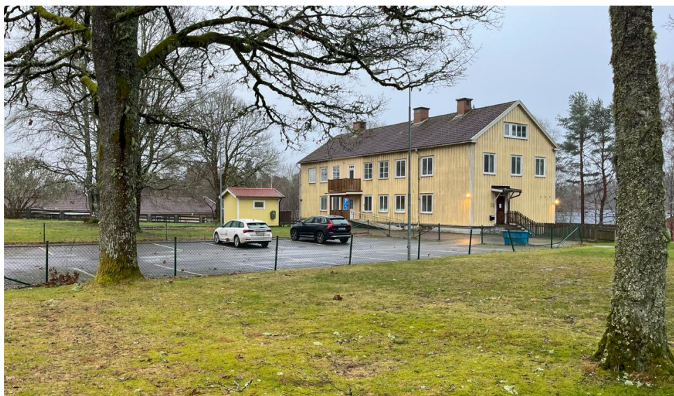
Byggnaden från sydväst. Bildkälla: Norconsult
