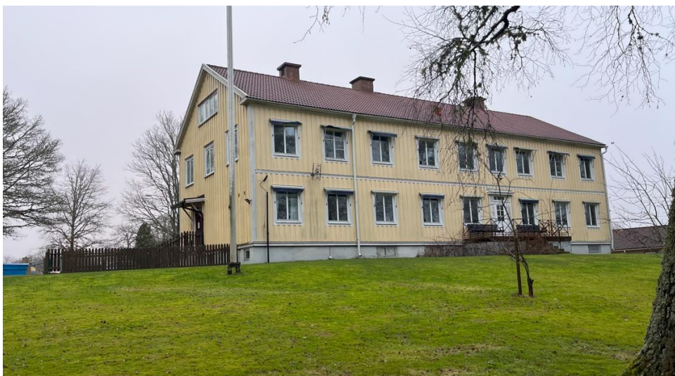
Nedan: Byggnaden från nordväst. Bildkälla: Norconsult
