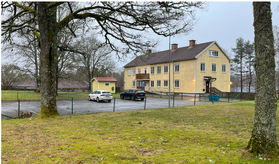
Byggnaden från sydväst. Bildkälla: Norconsult
