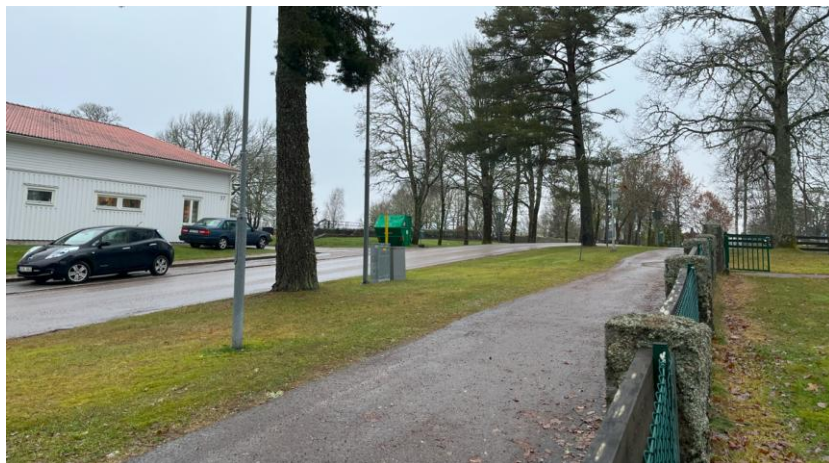
Gång- och cykelväg utmed Gamla Edsvägen
