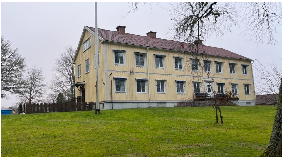
Byggnaden från nordväst. Bildkälla: Norconsult
